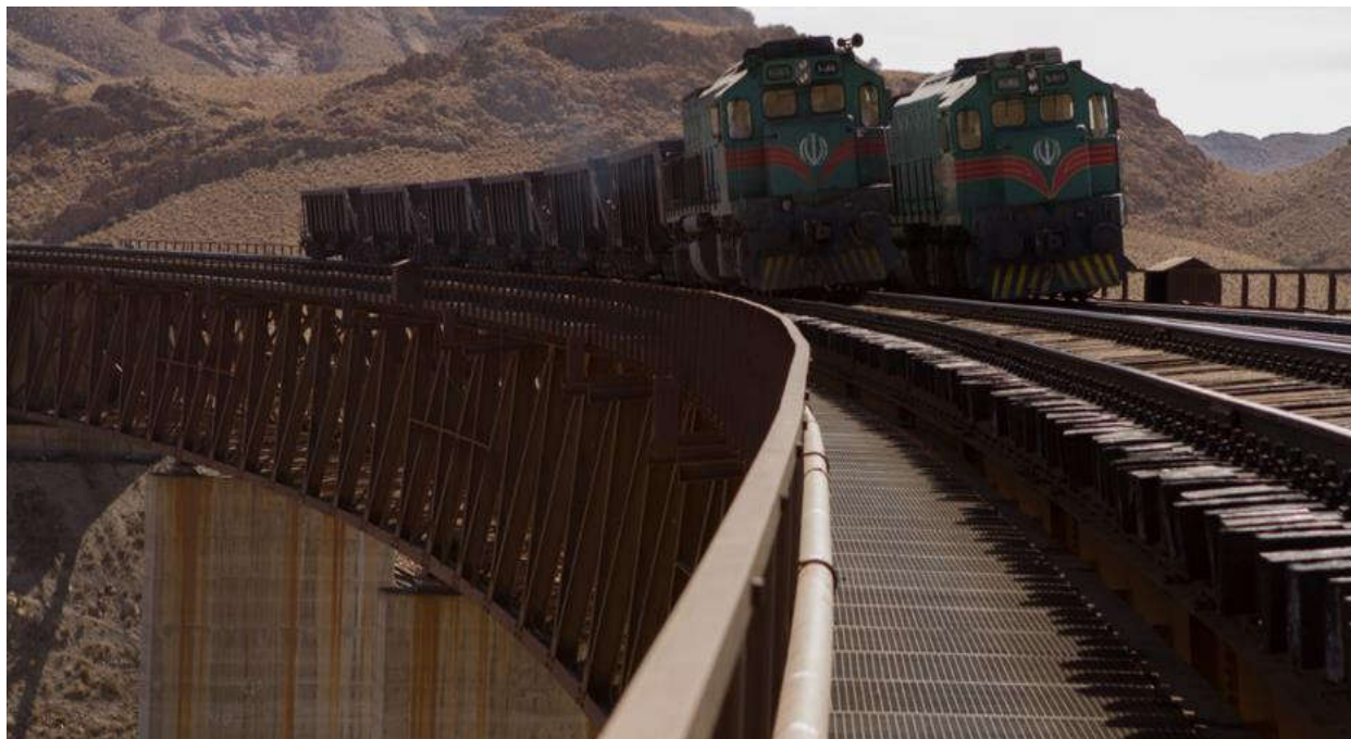
آزمایش بارگذاری دینامیکی پل ۱۰۳۵
