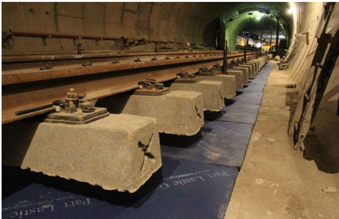
استفاده از فرش جاذب ارتعاشات ریلی: خط ۶ مترو تهران (خط بدون بالاست)
