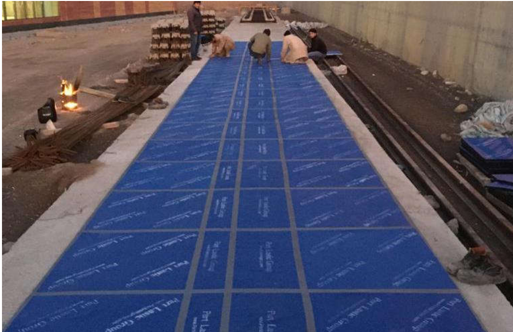
استفاده از فرش جاذب ارتعاشات ریلی: خط ۱ مترو تبریز (دپوی لاله)
